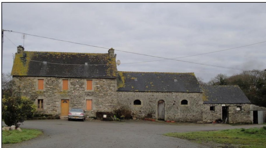
Photo n°5 : Vue sur un bâtiment à caractère patrimonial
