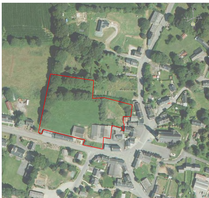
Photo aérienne du site (source : Géoportail)
