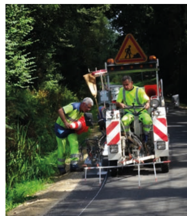
Travaux de marquage au sol réalisés dans le bourg et à Saint Eloi. Coût : 1 957 €
